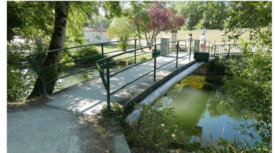
Passerelle béton / acier
