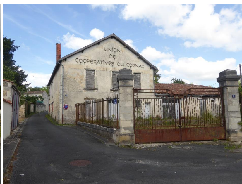
Le bâtiment de l'union de oopérative du Cognac
