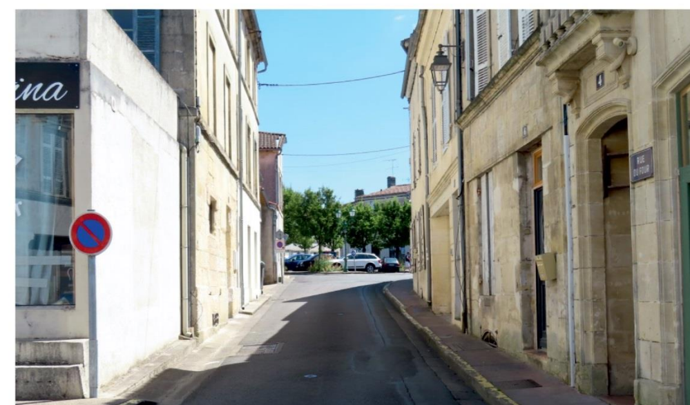
Aménagement des rues du centre-ville et ses abords – enrobé bitumineux
