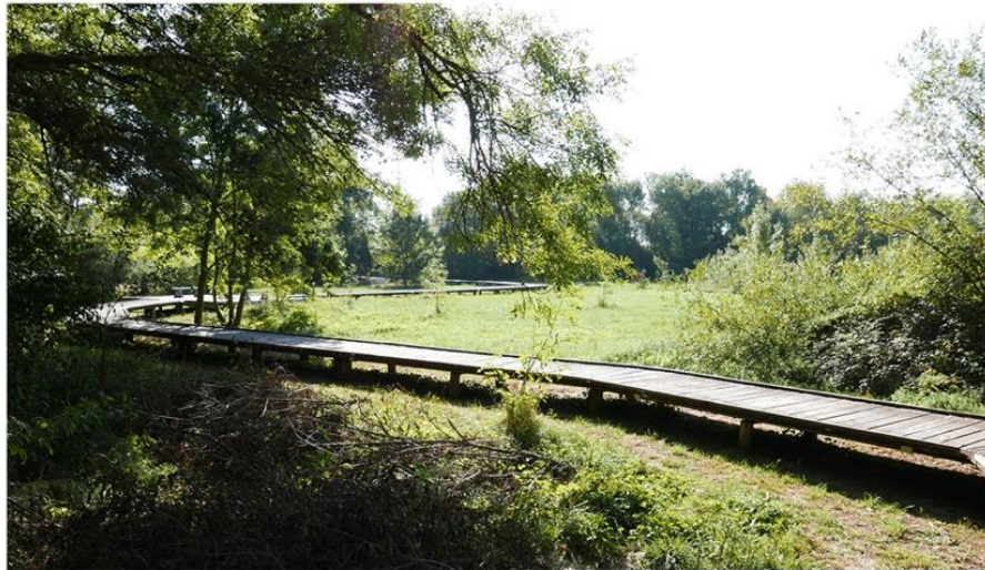
Platelage bois sur pilotis
