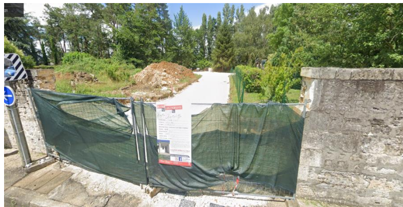
maisons en construction rue Félix Faure
