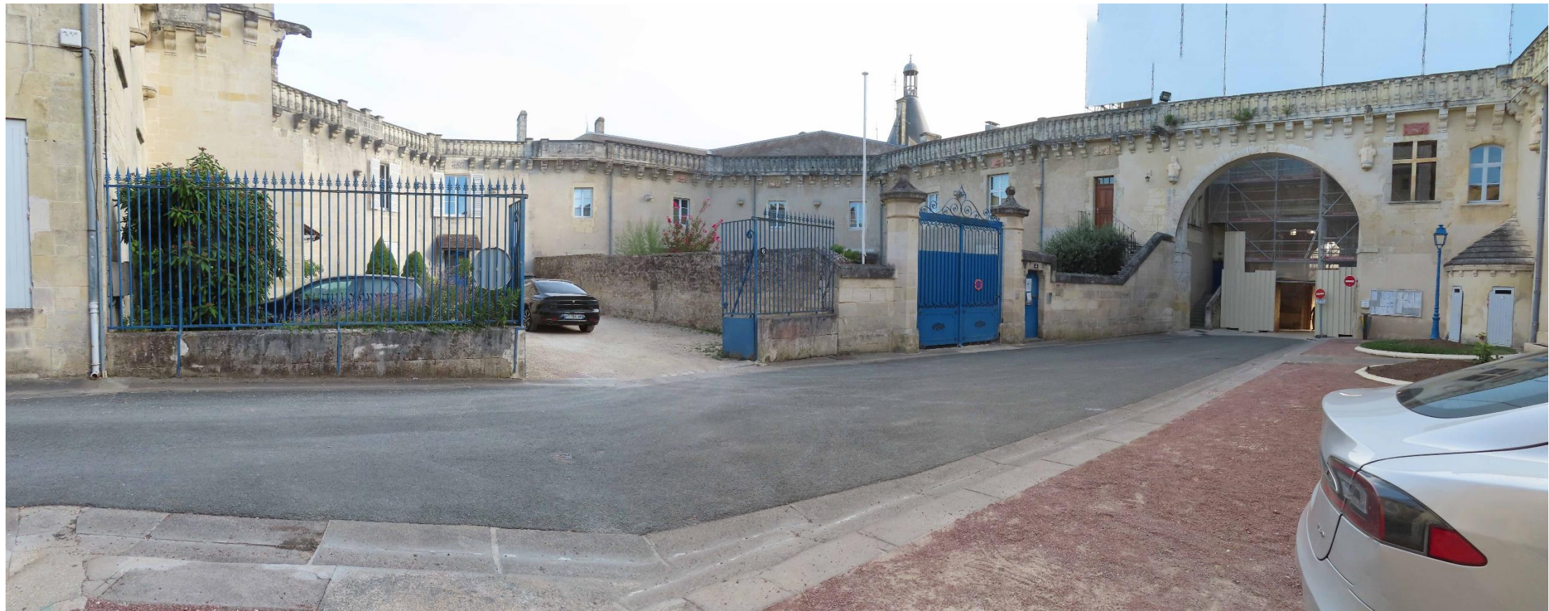
Une cour de château morcellée, traversée par une rue et décevante pour le visiteur.
