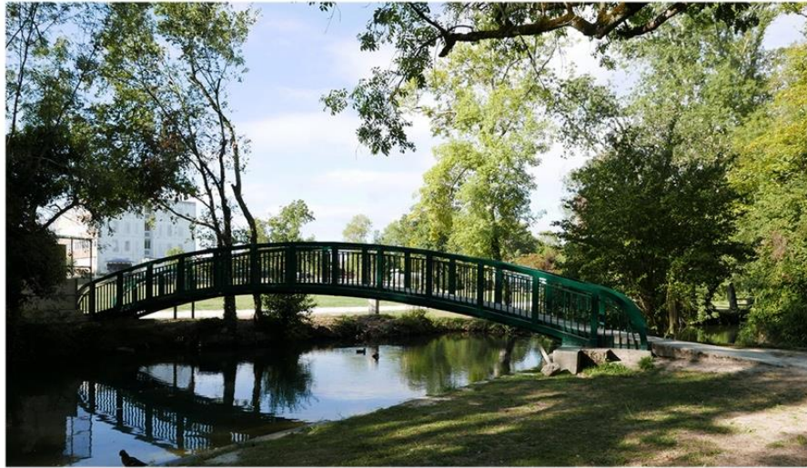
Passerelle béton / acier
