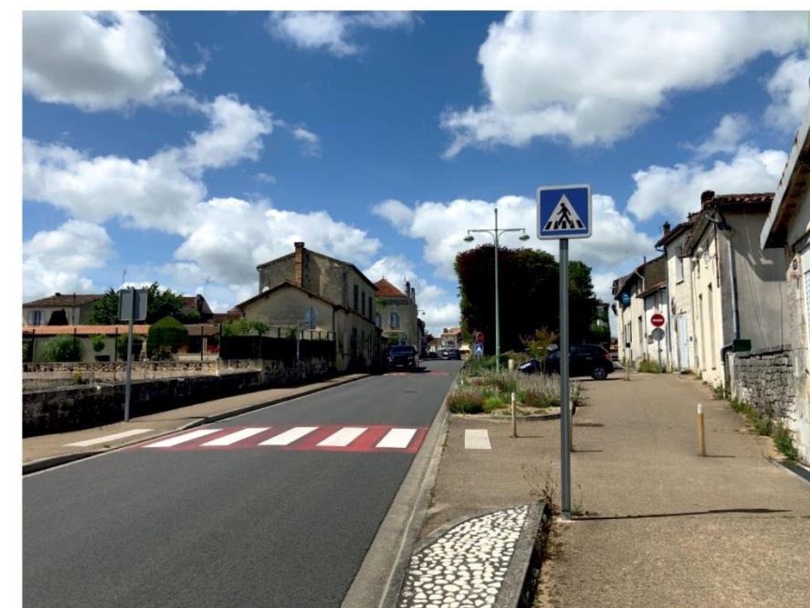
Aménagement de Boulevards – enrobé coloré
