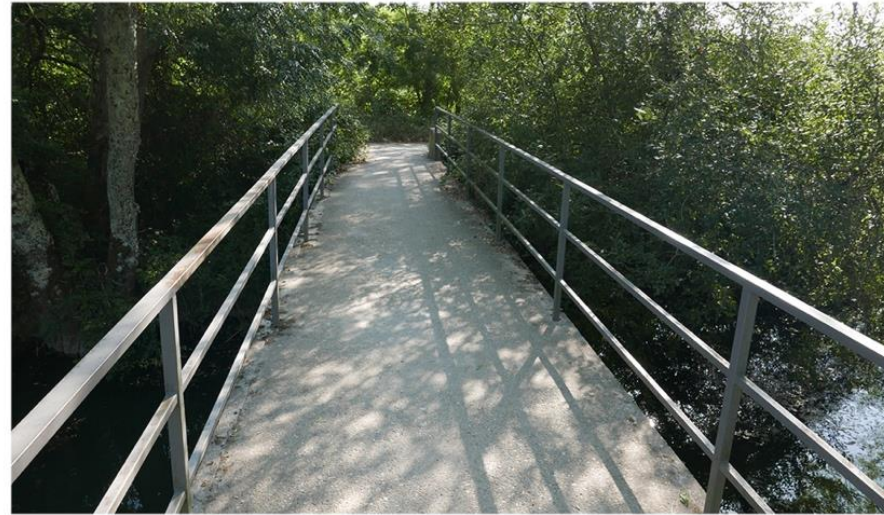
Passerelle béton / acier
